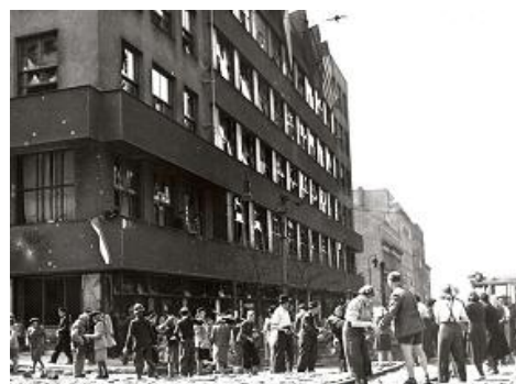
Stavba barikády u rozhlasu
